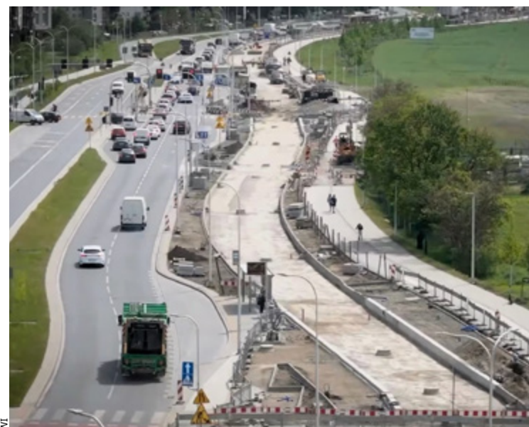
Budowa buspasa na Jagodno, na którym będzie torowisko tramwajowe
